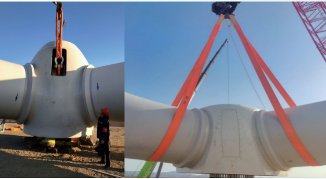
图12 叶轮整体式吊装
