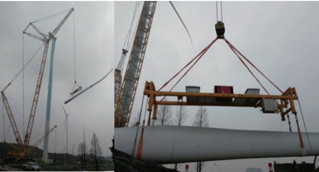
图13 单叶片式吊装
