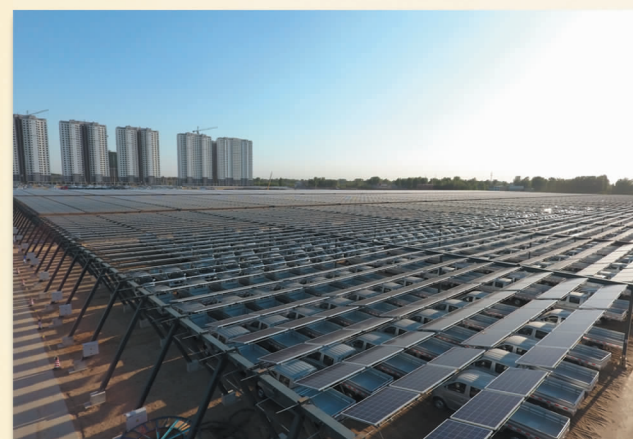
国内跨距最大的柔性支架光伏项目——河北长安12兆瓦分布式光伏发电项目（2017年）
